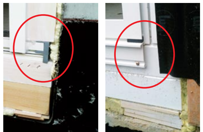
Abb. 19: undichte und flächenversetzte Übergänge mit Materialwechsellern müssen gemäss Kapitel 10 erstellt werden
