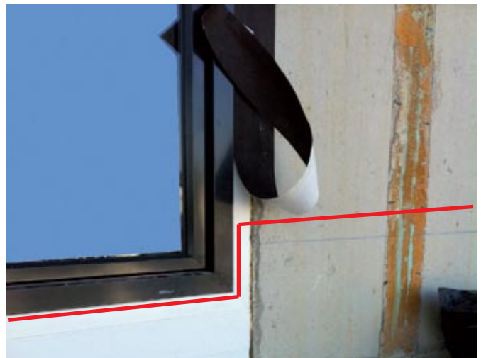
Abb. 20: Winddichtungs- oder Schlagregendichtungsbänder im Flachdachanschlussbereich hochklappen
